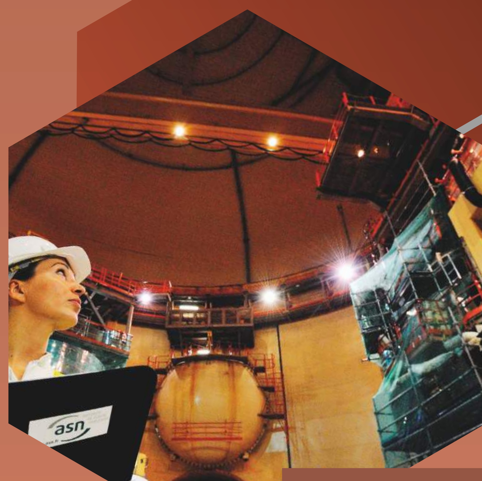
Contrôle de la centrale du Tricastin.
