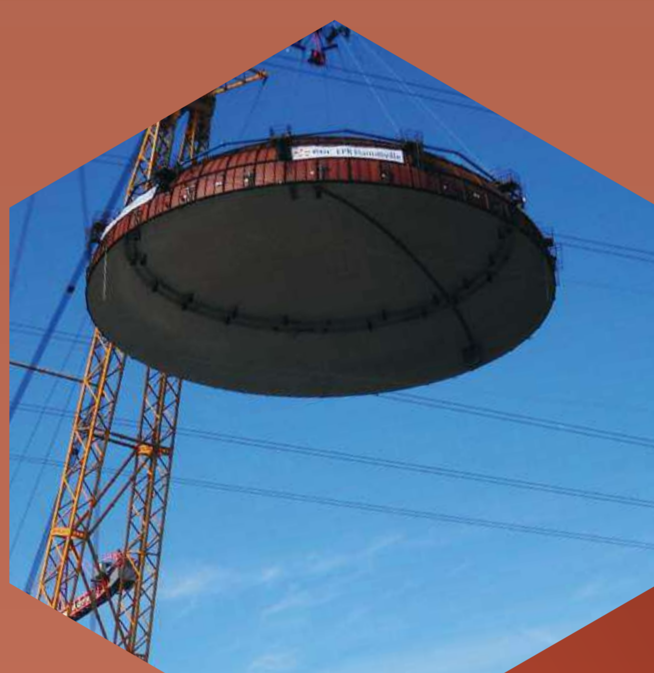
Construction du réacteur EPR de Flamanville.
